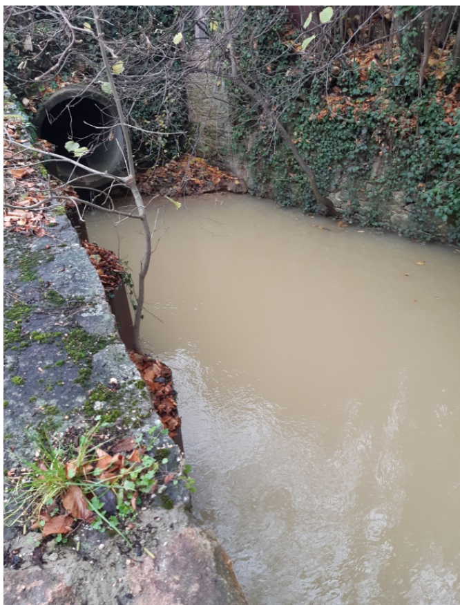
Source grouillante, avec conduite pour les eaux de pluie.
